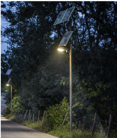
Die Solarleuchte besteht aus einem Kandelaber mit aufgeständerten Solarmodulen. Diese sind, wie der Leuchtenkopf, mit Auslegern am Kandelaber befestigt. So ist die Orientierung frei wählbar. Der Controller ist im Kandelaber untergebracht, die Akkus in einer separaten Erdbox.
