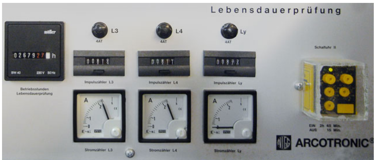
Abbildung 3: Steuereinheit für die Lebensdauerprüfung; eine analoge Einheit wurde für die Schaltfrequenz eingerichtet.
