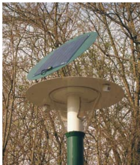
Fig. 3: Les lampadaires solaires combinés avec des détecteurs de mouvements conviennent parfaitement à l'éclairage de chemins piétonniers. Sur la photo, un projet pilote à Zumikon.
